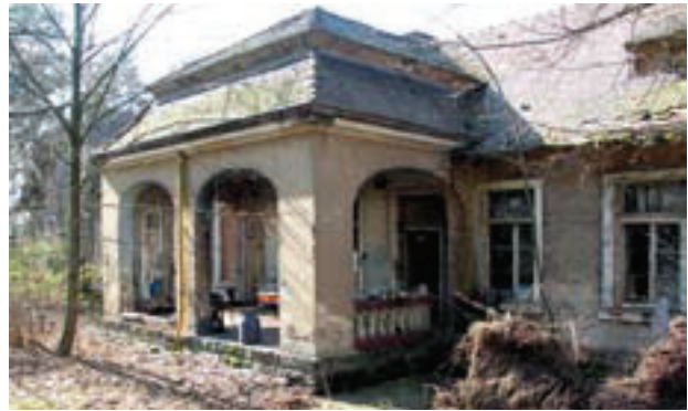
Abb. 23 Gebäude vor der Sanierung
