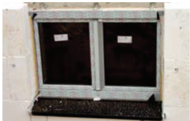
Abb. 20 Einbau passivhaustaugliches Fenster
