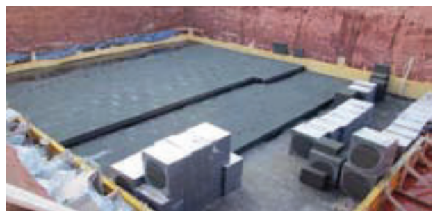
Abb. 2 Schaumglasplatten-Verlegung unter Bodenplatte
