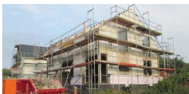
Abb. 3 Abschluss der Rohbauarbeiten
