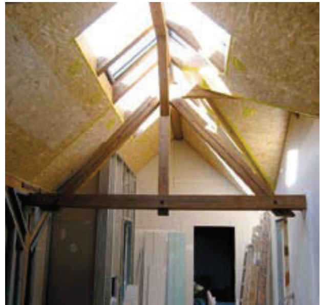
Abb. 26 Einbau von Dachfenstern im Firstbereich
