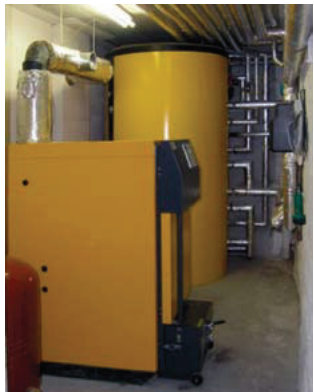
Abb. 27 Pelletkessel Heizung
