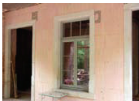
Abb. 25 Fenster und Außendämmung © SAENA
