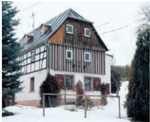
Abb. 28 Gebäude vor der Sanierung
