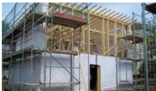
Abb. 11 Fertigstellung Holzrahmenbau
