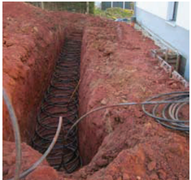
Abb. 6 Verlegung des Ringgrabenkollektors © SAENA
