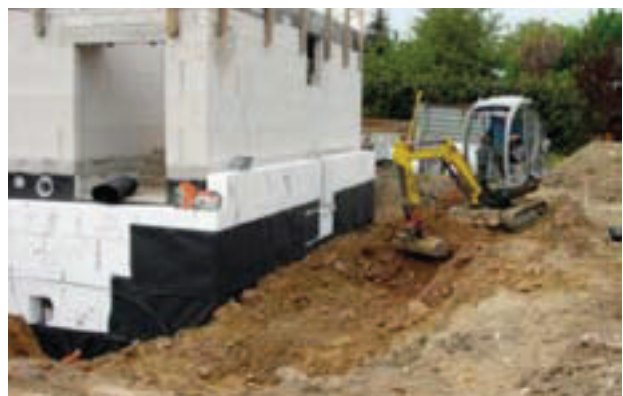
Abb. 21 Außenwand mit Dämmung
