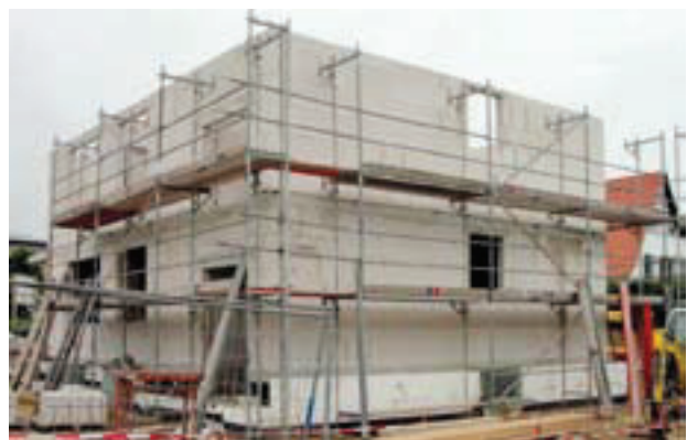
Abb. 19 Gebäude während der Bauphase
