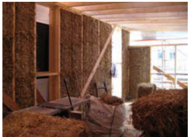
Abb. 13 Einbau der Strohballen in die Gefache
