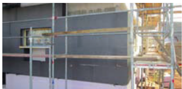
Abb. 4 Installation der Außendämmung
