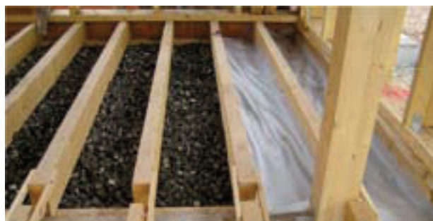
Abb. 10 Erstellung Holzbodenplatte auf Schaumglasschotter © SAENA
