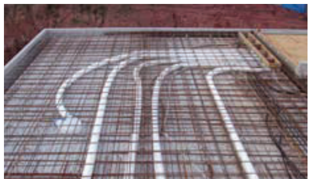
Abb. 7 Installation der Lüftungsleitungen © SAENA
