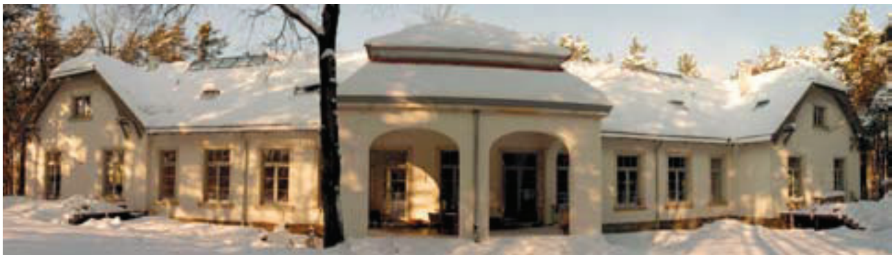
Abb. 24 Gebäude nach der Sanierungsmaßnahme
