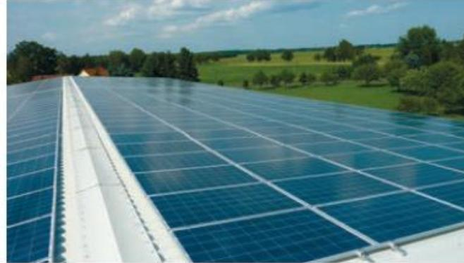
Abbildung 39: Dachparallele Montage auf Trapezblech
