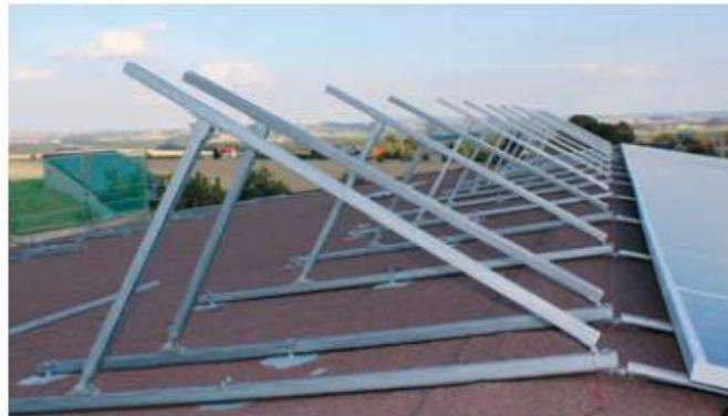
Abbildung 42: Aufgeständerte Montage mit Aluminium-Gestellen auf Bitumendach
