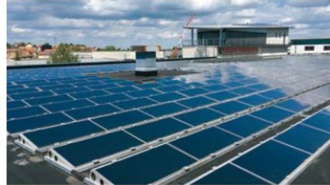
Abbildung 40: Aufgeständerte Montage mit Kunststoffwannen
