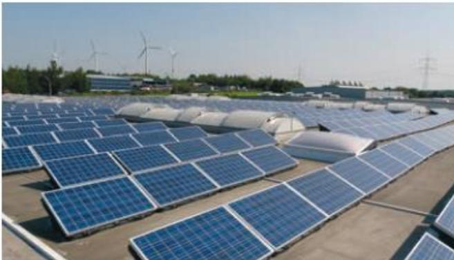
Abbildung 41: Aufgeständerte Montage mit Kunststoffwannen
