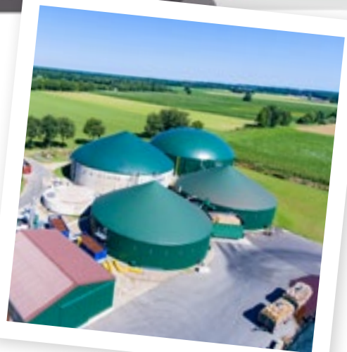
Heute: In einer Biogasanlage werden Strom, Wärme und Gas aus Biomasse produziert.
