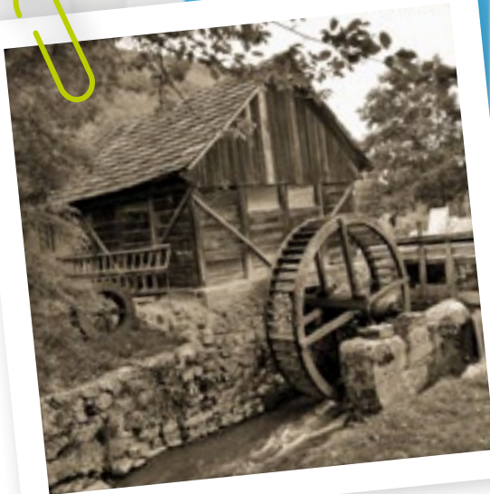
Früher: Wassermühlen nutzen die Kraft des Wassers zum Mahlen von Getreide zu Mehl.
