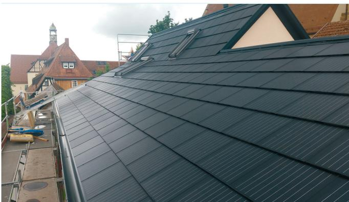
Abbildung 46: Solardachziegel in Flachziegeloptik
