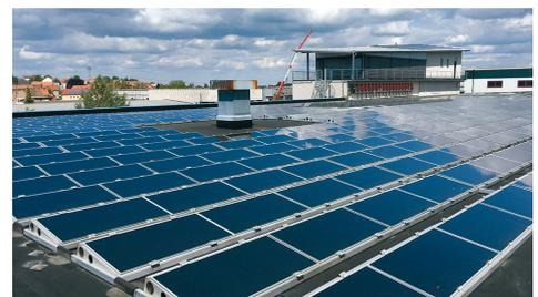
Abbildung 40: Aufgeständerte Montage mit Kunststoffwannen
