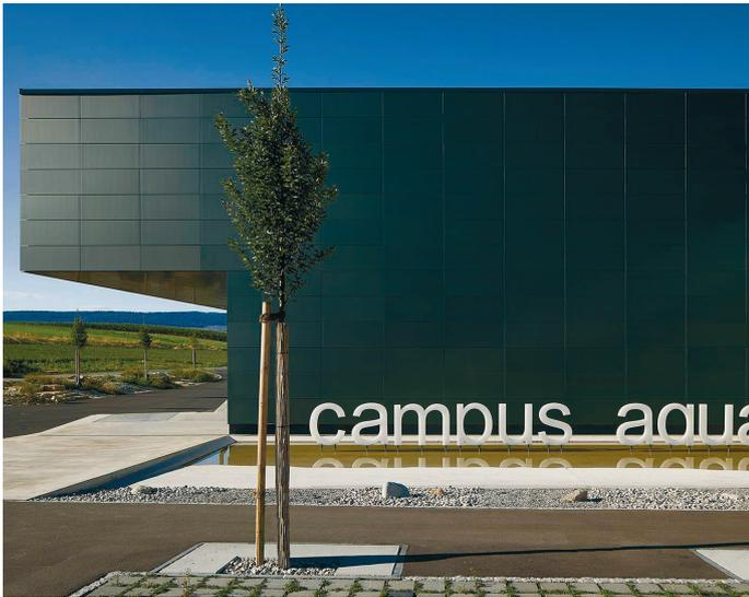
Abbildung 17: Fassade mit grünen Dünnschichtmodulen (CIS)
