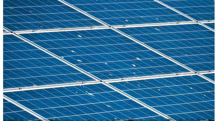
Abbildungen 66 / 67: Verschmutzung von PV-Modulen durch Staub und Tierkot
