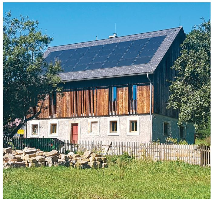
Abbildung 113: Denkmalgeschütztes Wohnhaus mit einer Indach-PV-Anlage und Schiefereindeckung
