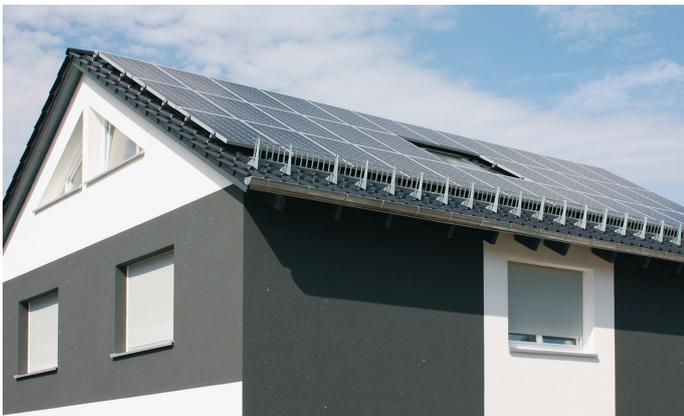
Abbildung 29: Aufdach-Montage eines Solargenerators
