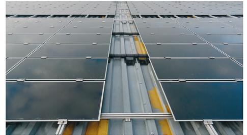
Abbildung 37: Montage auf Trapezblechdach
