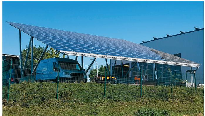
Abbildung 55: Solar-Carport mit Dünnschicht-Modulen
