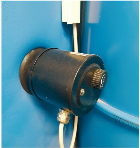
Abbildung 91: Nicht regelbarer Heizstab mit 2 kW in einem Pufferspeicher
