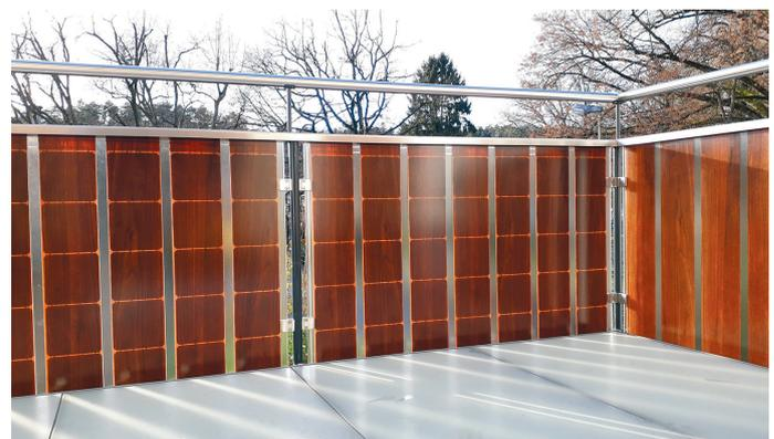
Abbildung 53: Balkonbrüstung mit Solar-Glas
