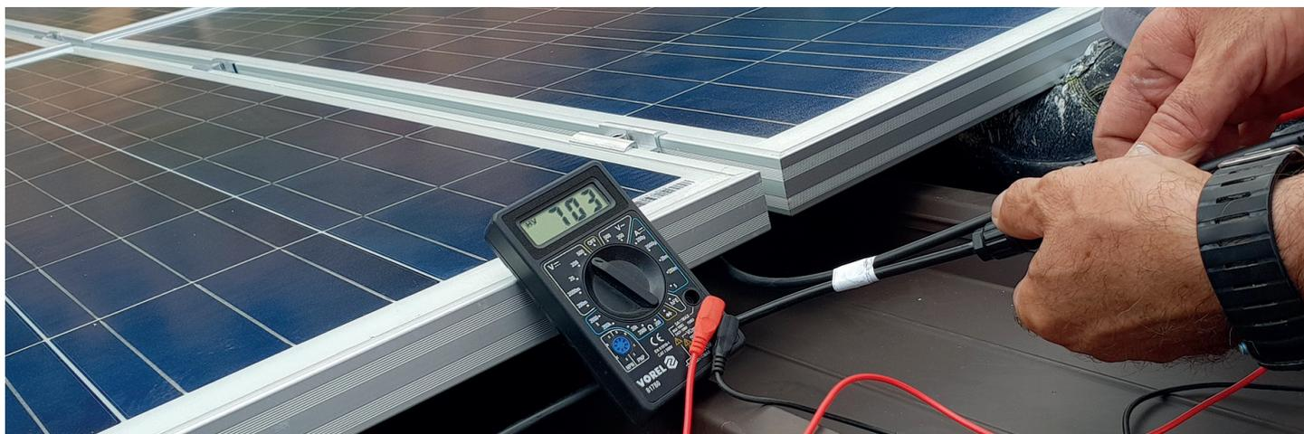
Abbildung 115: Funktionstest von Solarmodulen
