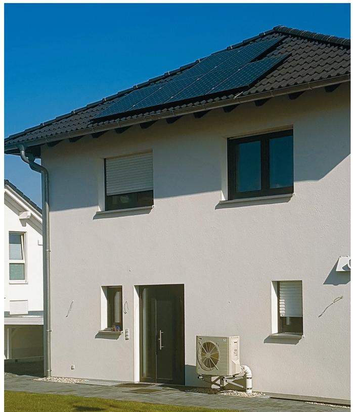
Abbildung 83: Kombination Luft-Wasser-Wärmepumpe mit PV-Anlage
