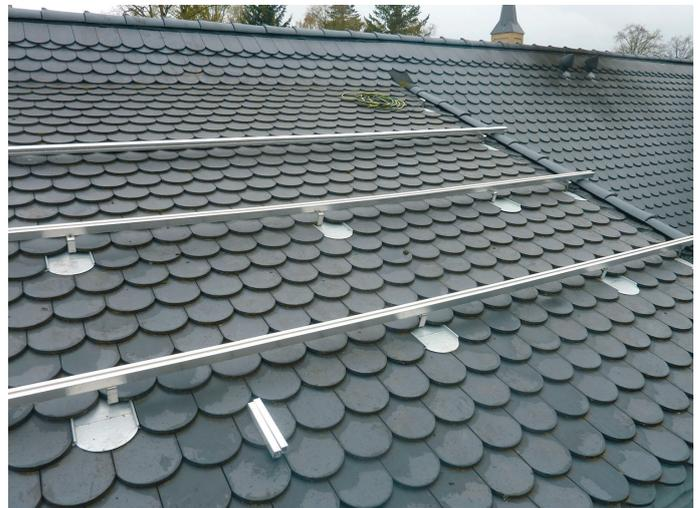
Abbildungen 30/31: Befestigungssysteme mit Montageschienen (einlagig) und Dachhaken auf Blechziegeln
