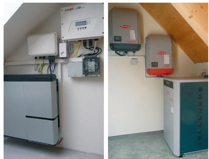
Abbildungen: 76 / 77: Installierte Solarstrom-Speichersysteme
