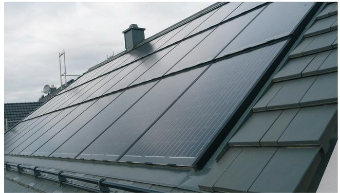
Abbildung 45: Fertige Indach-Anlage mit Glas-Glas-Modulen
