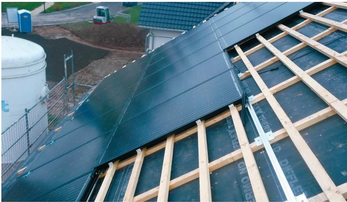
Abbildung 44: Indach-Montage mit Glas-Glas-Modulen
