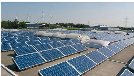
Abbildung 41: Aufgeständerte Montage mit Kunststoffwannen
