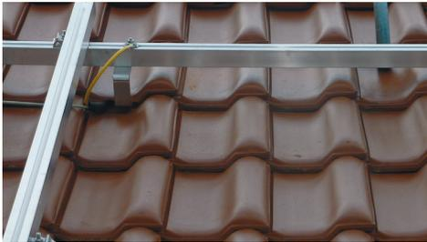
Abbildung 35: Anschluss Potentialausgleich am Befestigungssystem
