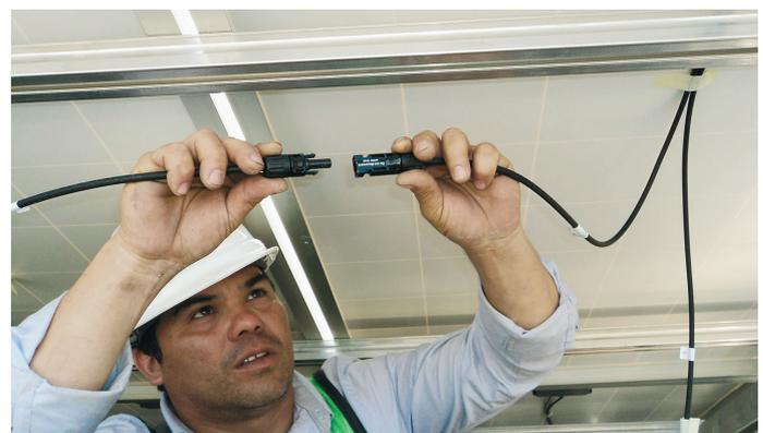
Abbildung 24: Verbindung von Solarmodulen mit MC4-Steckverbinder
