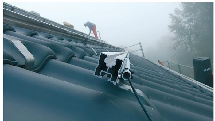
Abbildung 23: Verlegung von Solarkabeln in Schutzrohren
