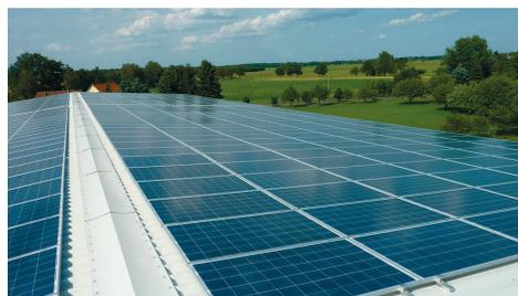
Abbildung 39: Dachparallele Montage auf Trapezblech
