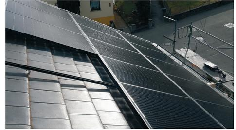
Abbildung 34: Modulbefestigung mit K2 Systems Einlegesystem
