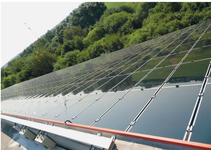
Abbildung 18: Aufdach-Anlage mit Dünnschicht-Modulen (CIS)
