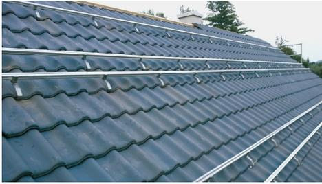
Abbildung 32: Befestigungssystem mit Montageschienen (einlagig) und Dachhaken
