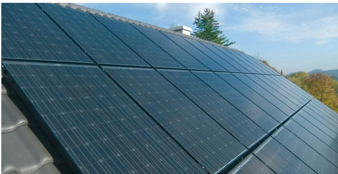
Abbildung 11: Aufdach-Anlage mit monokristallinen Dickschichtmodulen
