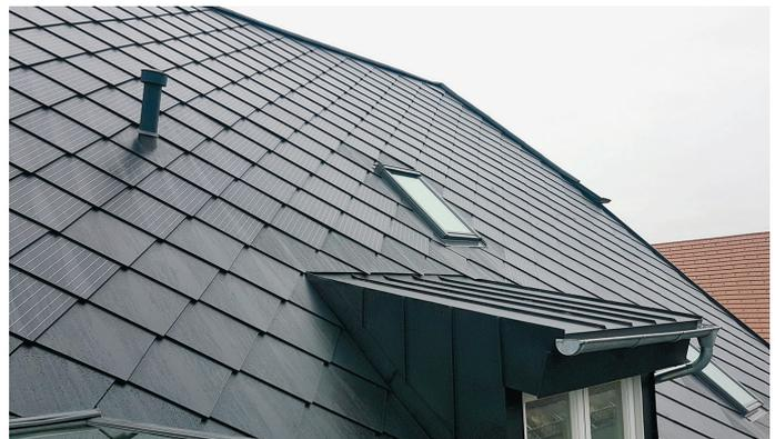
Abbildung 47: Solardachziegel in Dachschieferoptik
