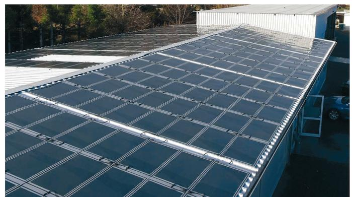
Abbildung 19: Aufdach-Anlage mit Dünnschichtmodulen (CIGS)
