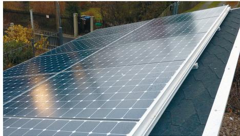
Abbildung 36: Montage auf Bitumenschindeln
