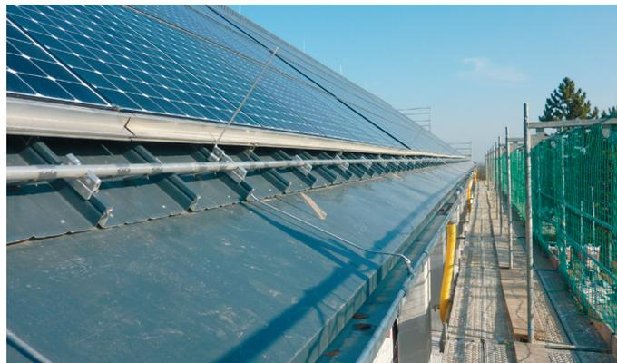
Abbildung 107: Installation von Photovoltaik- und Blitzschutzanlage
