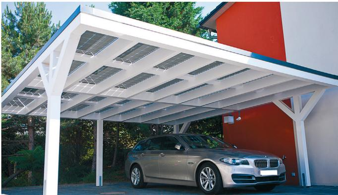
Abbildung 54: Solar-Carport mit Glas-Glas-Modulen
