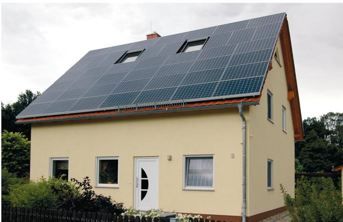
Abbildung 109: Optimale Dachausnutzung trotz Dachfenstern
