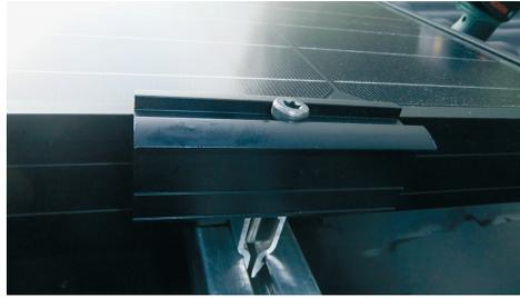
Abbildung 33: Modulklemme zur Fixierung von PV-Modulen
