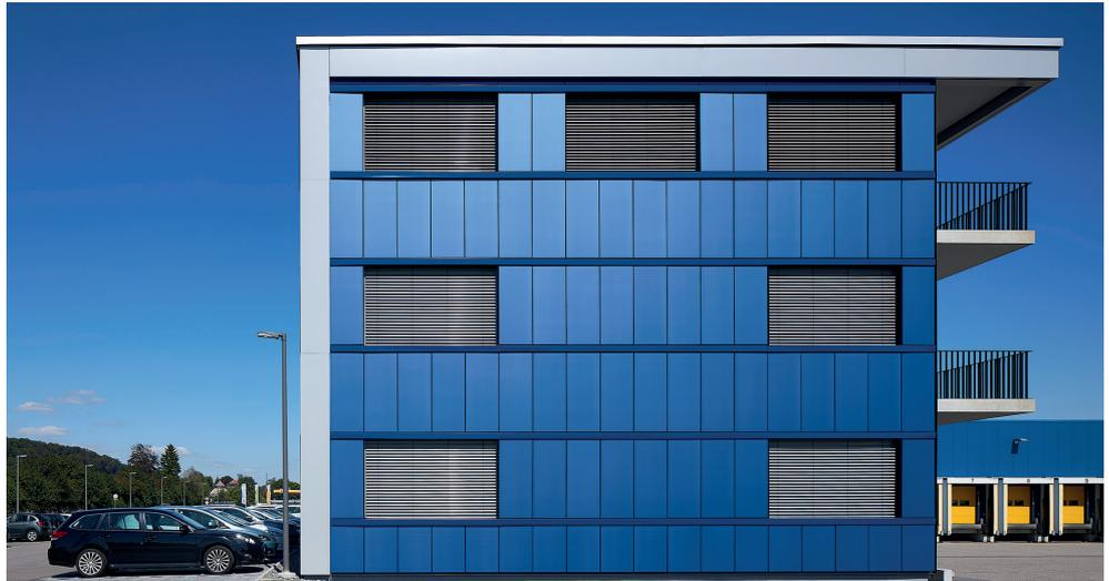
Abbildung 49: Fassadenanlage mit blauen Dünnschichtmodulen
