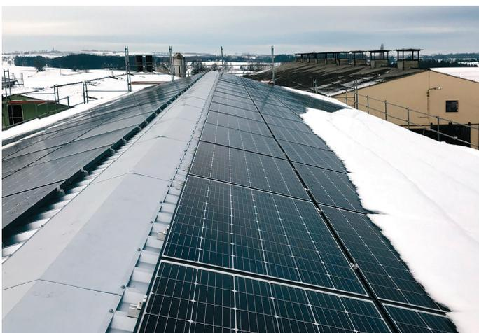
Abbildung 68: Schnee auf Solargenerator
