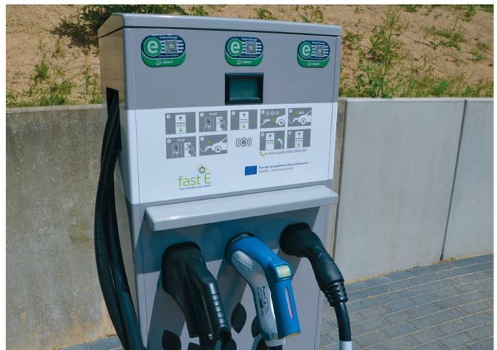
Abbildung 102: Schnellladestation mit verschiedenen Ladesystemen
