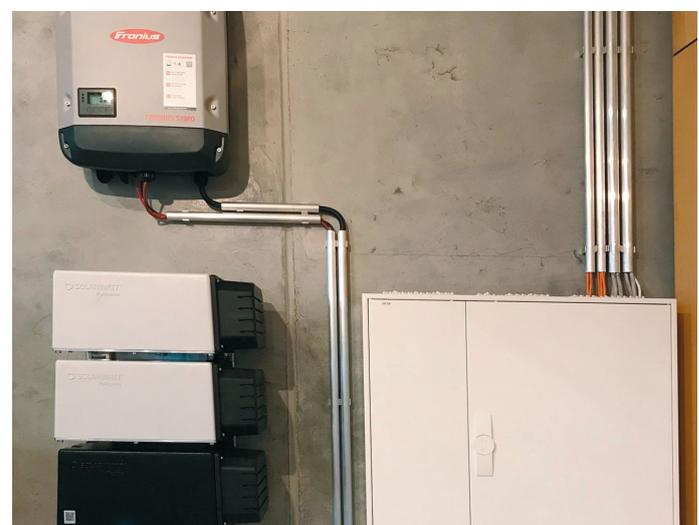
Abbildung 73: Modular erweiterbares Stromspeichersystem
