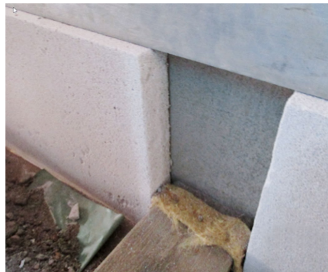
Einbindung eines Holzbalkens in eine innen gedämmte Außenwand
