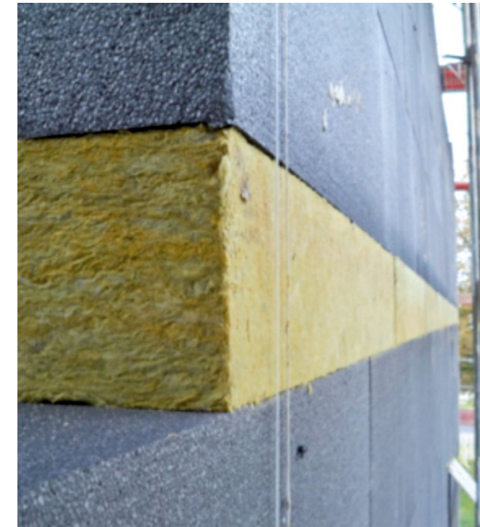
Brandriegel aus Mineralwolle
