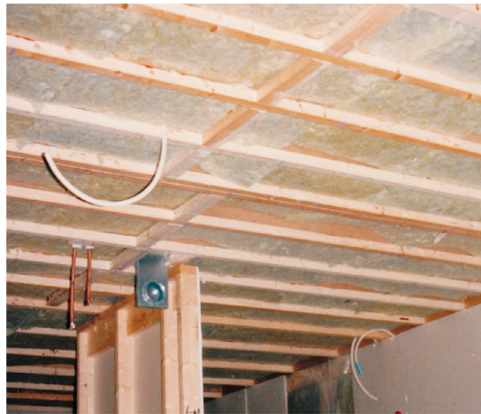
Unterdeckendämmung aus Mineralwolle
