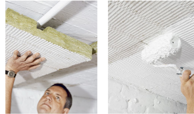
Anbringen einer mineralischen Unterdeckendämmung
