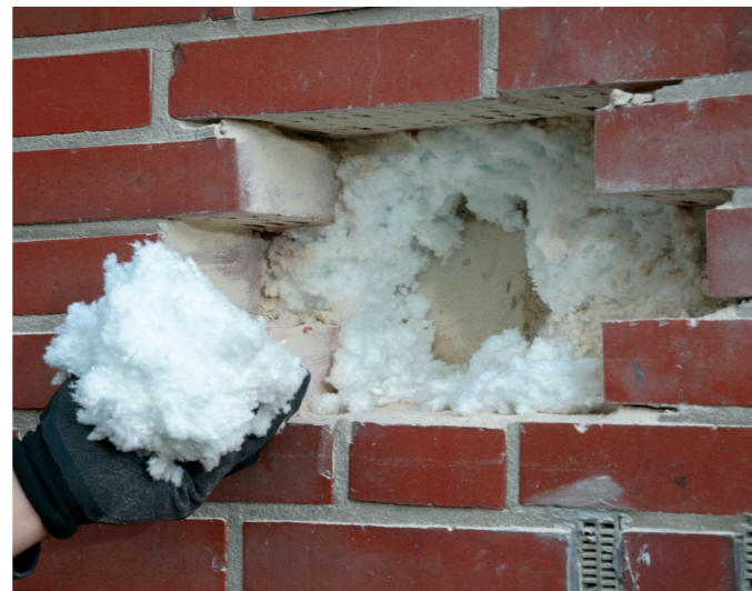
Eingeblasener Dämmstoff in einem zweischaligen Mauerwerk
