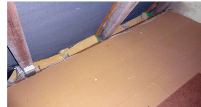
Holzfasern-Dämmplatten im Dachboden
