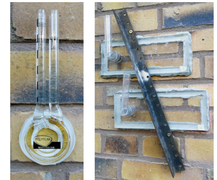
Messmethoden zur kapillaren Wasseraufnahme an Fassaden: Prüfröhrchen nach Pleyers und Prüfplatte nach Dr. Franke
