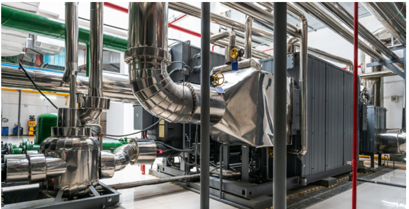
Absorptionskältemaschine (WEGRACAL SE 200) mit Stoffpaarung Wasser/LiBr und 200 kW Kälteleistung (Kühlwasser bei 9 °C). Bestehend aus Verdampfer-Absorber-Einheit (vorn) und Kondensator-Austreiber-Einheit, heißwasserbetrieben (266 kW, 86 °C, \zeta=0,75 ). Quelle: istock/imantsu
