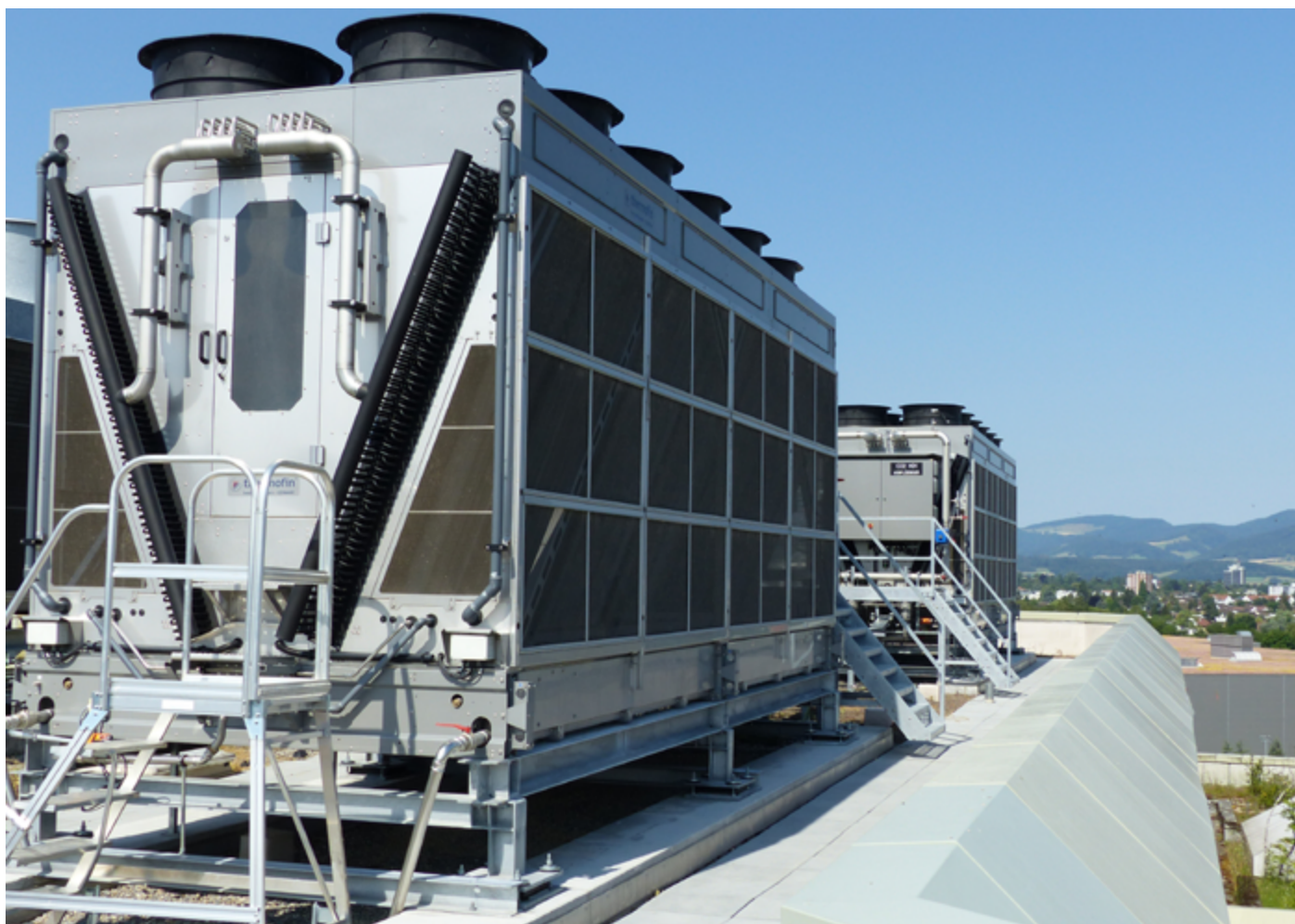
Thermofin Hybridkühler für besonders niedrige Rücklauftemperaturen
