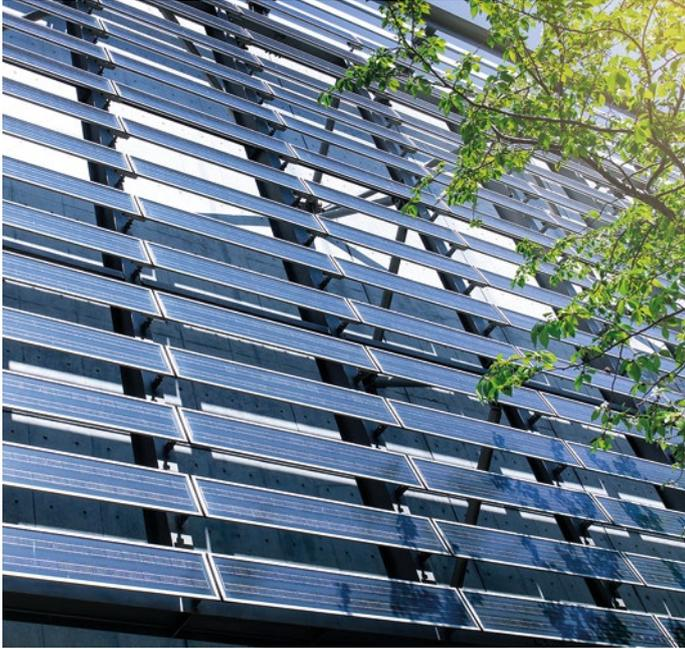
Abbildung 39: Bauwerkintegrierte Photovoltaikanlage
