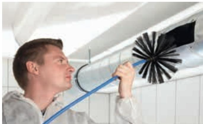
Abb. 79 Trockenreinigung eines Lüftungskanals mit einer Rotationsbürste (Biegewelle)
