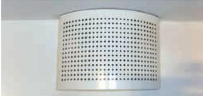
Abb. 32 Zuluftdurchlass (ZuLD) für Wand
