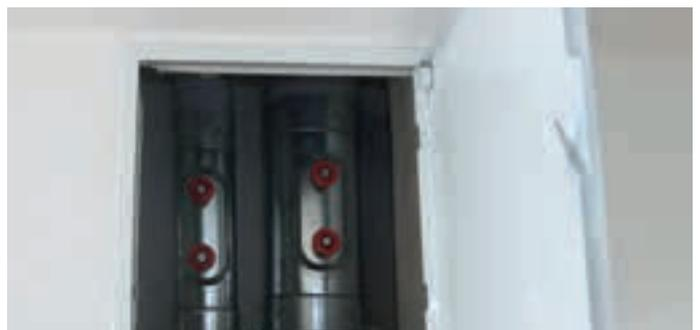
Abb. 36 Revisionsklappe in Trockenbauwand mit Reinigungsöffnungen in den Luftkanälen
