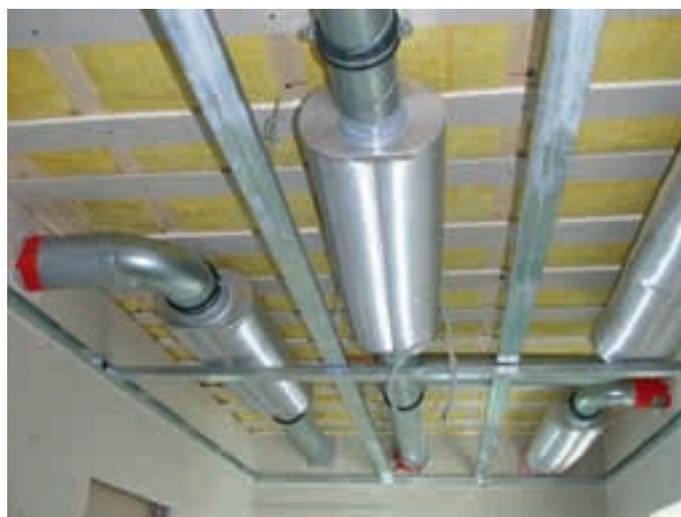
Abb. 81 Luftrohre inkl. Schalldämpfer
