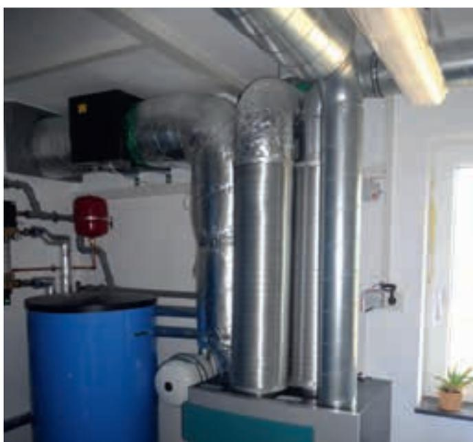
Abb. 72 Wärmedämmte Außenluft- und Fortluftleitung
