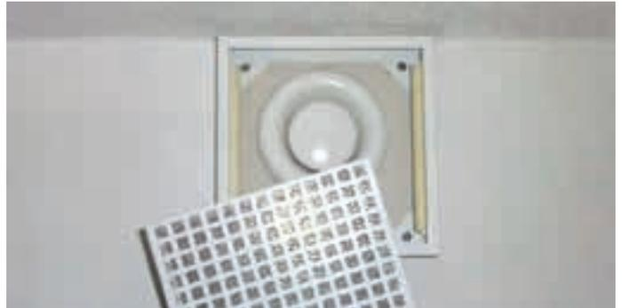
Abb. 35 Abluftdurchlass mit Vorschaltfilter für Wand und Decke
