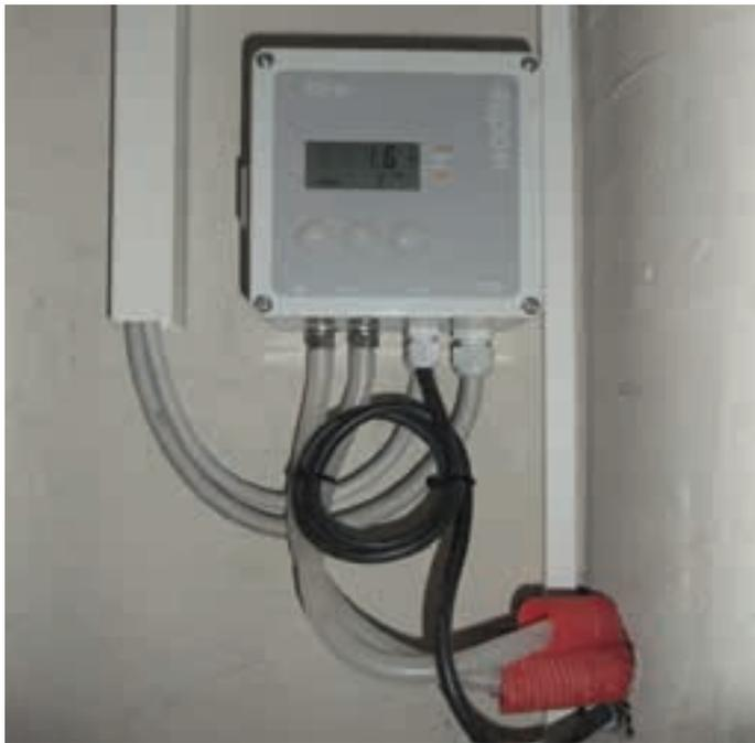
Abb. 56 Differenzdruckwächter mit abgehenden Druckschläuchen
