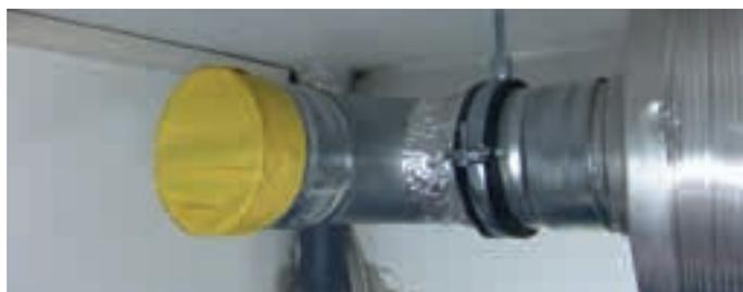
Abb. 73 Schutz vor Baustaub durch einfaches Abkleben von Öffnungen
