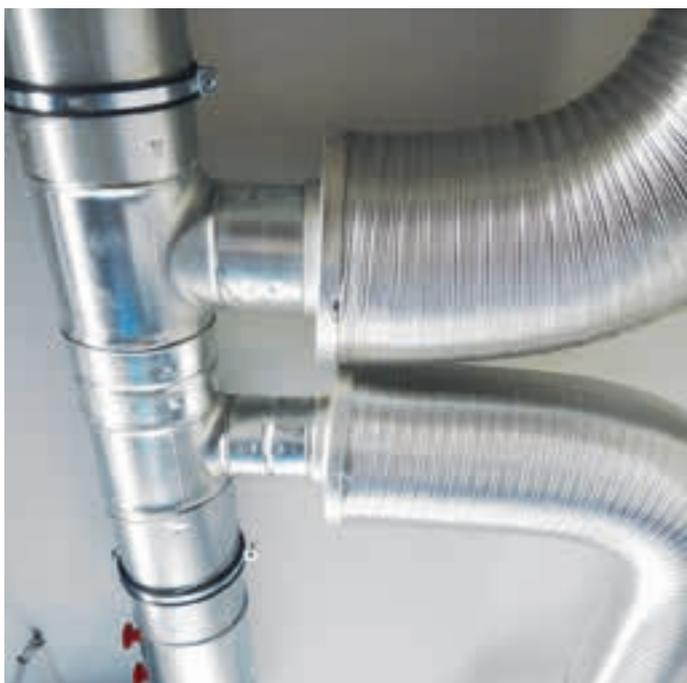
Abb. 70 Luftrohr mit Schalldämpfern
