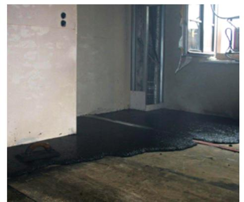
Abbildung 10: Links: Schematische Darstellung des Vorsorgekonzeptes „Anpassen“. Mitte: Anpassungsmaßnahmen im Erdgeschoss eines überflutungsgefährdeten, historischen Wohngebäudes an der Elbe. Steinsichtige Wandoberflächen. Rechts: Einbau eines Gussasphaltestrichs auf Schaumglas-Wärmedämmung zur Herstellung eines hohlraumfreien, wasserunempfindlichen Fußbodenaufbaus.
