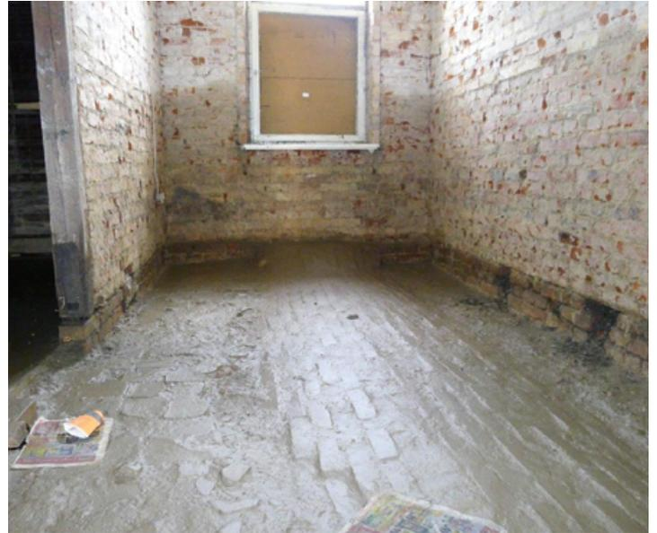
Abbildung 6: Links: Hochwasserschaden an einer historischen Holzbalkendecke: Durch die erhöhte Eigenlast nach vollständiger Überflutung sind Schalung und Deckenfüllung (Lehmschlag) abgestürzt. Rechts: Freigelegter Gewölberücken an einer gemauerten Kappendecke: Der Fußbodenaufbau musste wegen vollständiger Überflutung zurückgebaut werden.
