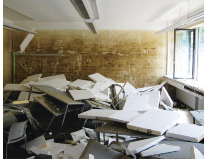
Abbildung 1: Hochwasserereignisse führen verstärkt zu Schäden an Gebäuden und Inventar, so wie in diesem Seminarraum nach nahezu vollständiger Überflutung. Die Fußbodenkonstruktion wurde durch Auftriebskräfte zerstört.
