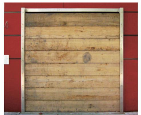
Abbildung 9: Links: Schematische Darstellung des Vorsorgekonzeptes „Widerstehen“. Mitte: Vertikalabdichtung gegen zeitweise von außen drückendes Wasser, ausgeführt mittels zweilagiger Polymerbitumen-Schweißbahnen. Rechts: Dammbalkensystem vor einer Türöffnung zum Schutz vor eindringendem Flutwasser.
