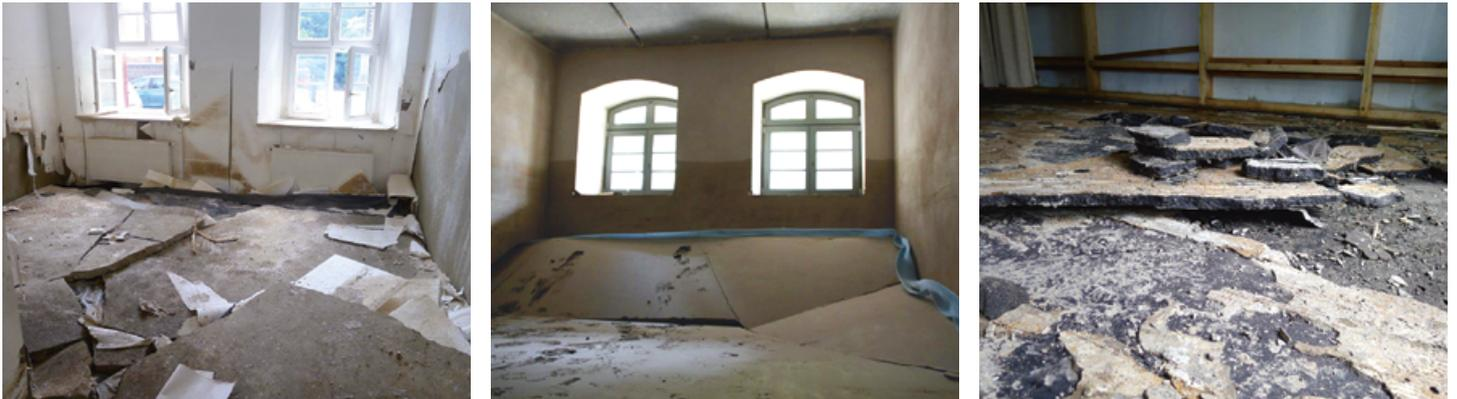
Abbildung 7: Schadensbilder an Fußbodenkonstruktionen mit verschiedenen Estricharten. Links: Zementestrich durch Auftriebskraft der Wärmedämmschicht (15 cm) zerstört. Mitte: Calciumsulfatestrich durch Auftriebskraft und Volumenvergrößerung zerstört. Rechts: Gussasphaltestrich durch Auftriebskraft des oberseitig verklebten Parkettbodens zerstört.
