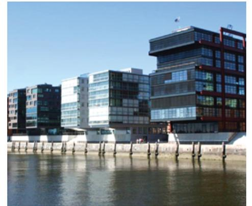
Abbildung 8: Links: Schematische Darstellung des Vorsorgekonzeptes „Ausweichen“. Mitte: Auf schlanken Pfeilern errichtetes Nichtwohngebäude an einem innerstädtischen Flutgraben in Dresden. Rechts: Wohn- und Bürogebäude in Warft-Bauweise in der Hafen-City Hamburg.
