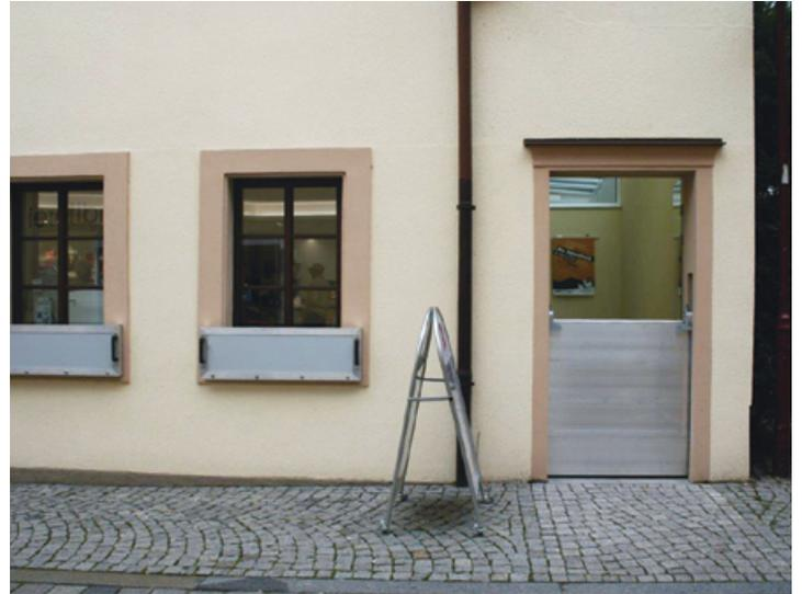
Abbildung 13: Testweise Montage der Schottplatten und Dammbalkensysteme vor den Gebäudeöffnungen.
