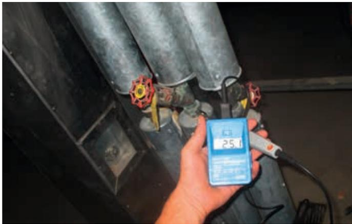
Abb. 46: Temperatur von nur 25,1°C in einem pumpenfernen Zirkulationsstrang (Quelle: Gutachterbüro Auerbach) eines nicht ausreichend abgeglichenen Systems
