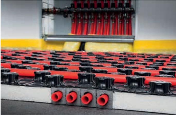
Abb. 7: Fußbodenaufbau Fußbodenheizung
