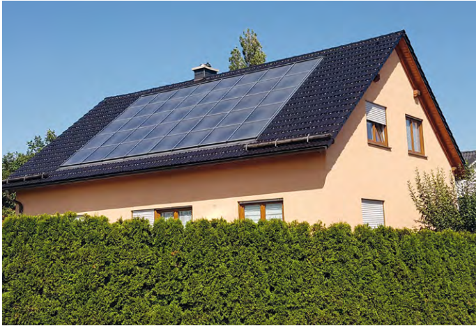
Abbildung 44: Solarthermieanlage (Indach-Montage)
