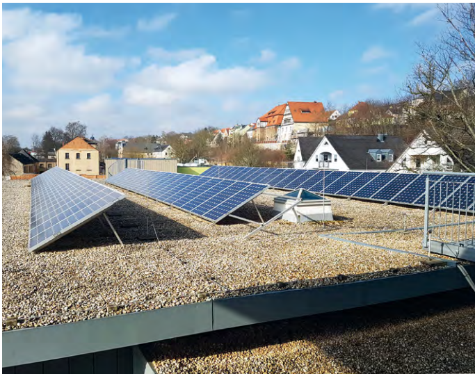
Abbildung 52: Aufgeständerte PV-Anlage auf einem Flachdach
