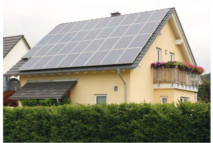
Abbildung 45: Photovoltaikanlage (Aufdach-Montage)
