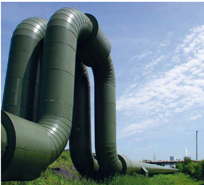
Abbildung 40: Oberirdische Fernwärmetrasse
