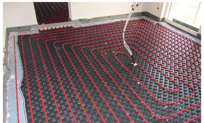
Abbildung 63: Einbau einer Fußbodenheizung
