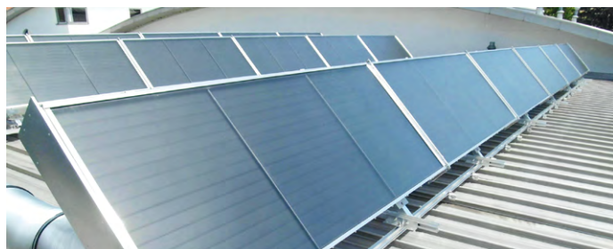
Abbildung 49: Solar-Luftkollektoranlage (aufgeständert)
