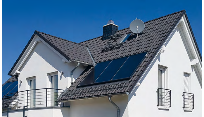
Abbildung 51: Kleine Solarthermieanlage (Indach-Montage)
