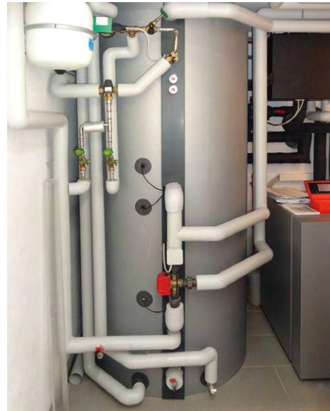
Abbildung 1: Neue Heizungsanlage mit Sole-Wasser Wärmepumpe und Pufferspeicher
