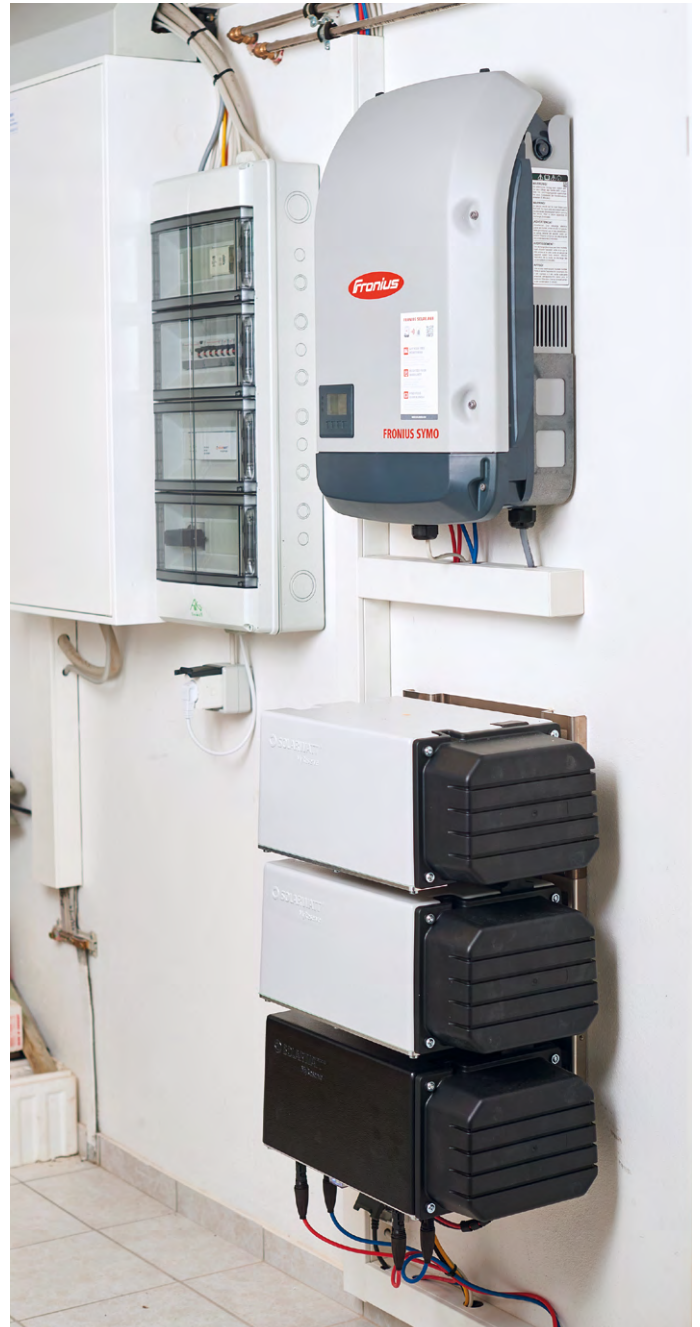
Abbildung 55: Modularer Stromspeicher mit PV-Wechselrichter
