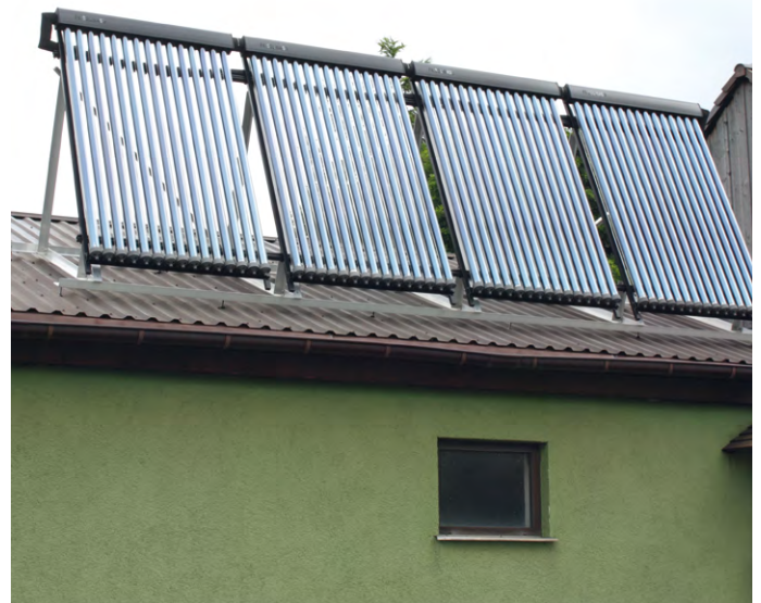
Abbildung 47: Vakuumröhrenkollektor (aufgeständert)
