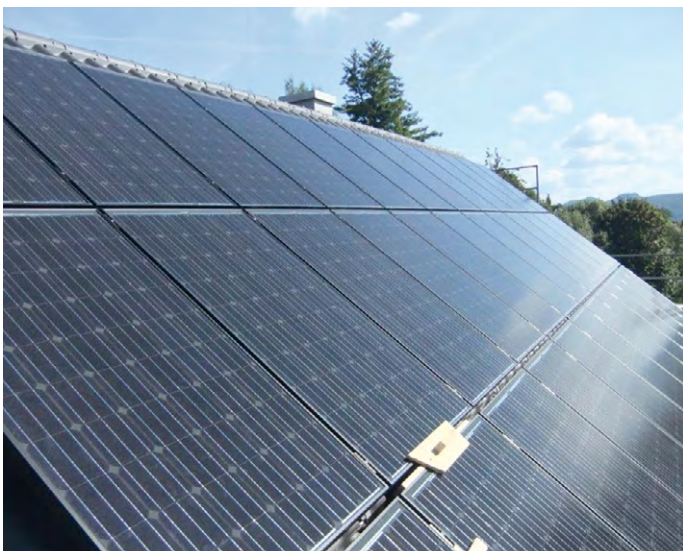
Abbildung 53: Photovoltaikanlage (Aufdach-Montage)
