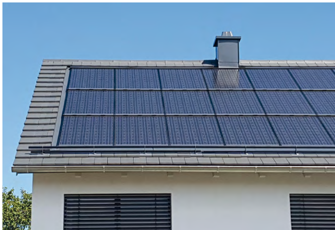
Abbildung 54: Photovoltaikanlage (Indach-Montage)
