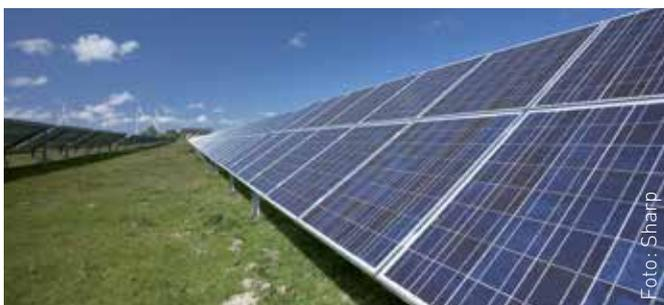
Beispiel: Ein Projektierer plant eine 20-MW starke PV-Freiflächenanlage im Außenbereich Ihres Gemeindegebietes. Dafür werden rund 20 ha Fläche benötigt. Der Standort hat eine gute Qualität. Bei dem Betrieb der Anlagen wird von 1.000 Volllaststunden im Jahr ausgegangen.
