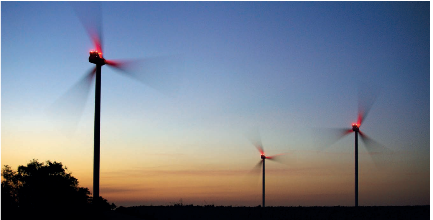
Abbildung 24: Nachtkennzeichnung von Windenergieanlagen
