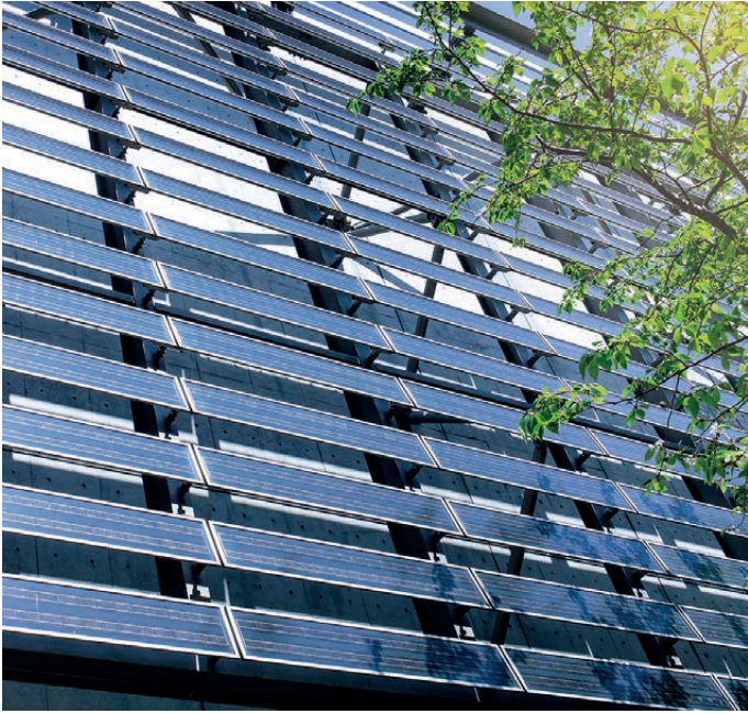
Abbildung 39: Bauwerkintegrierte Photovoltaikanlage
