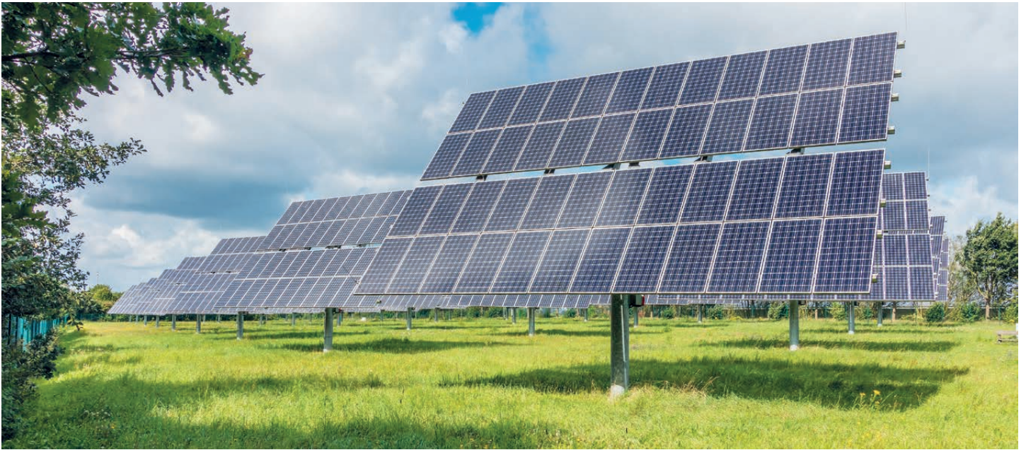
Abbildung 41: Zweiachsig nachgeführte PV-Anlage
