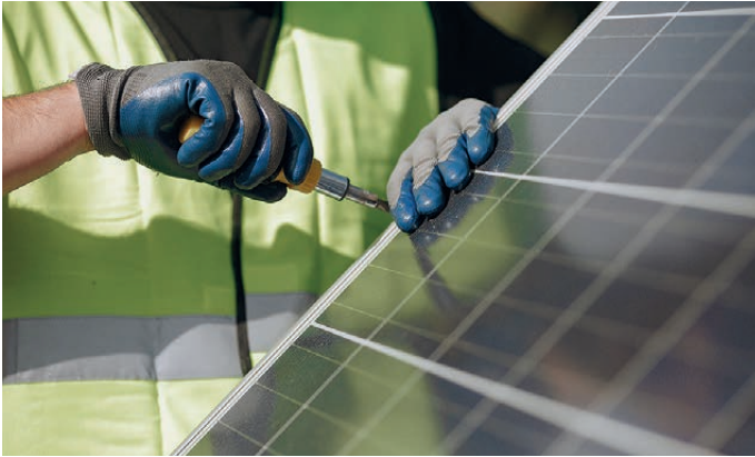
Abbildung 27: Installation einer Photovoltaikanlage
