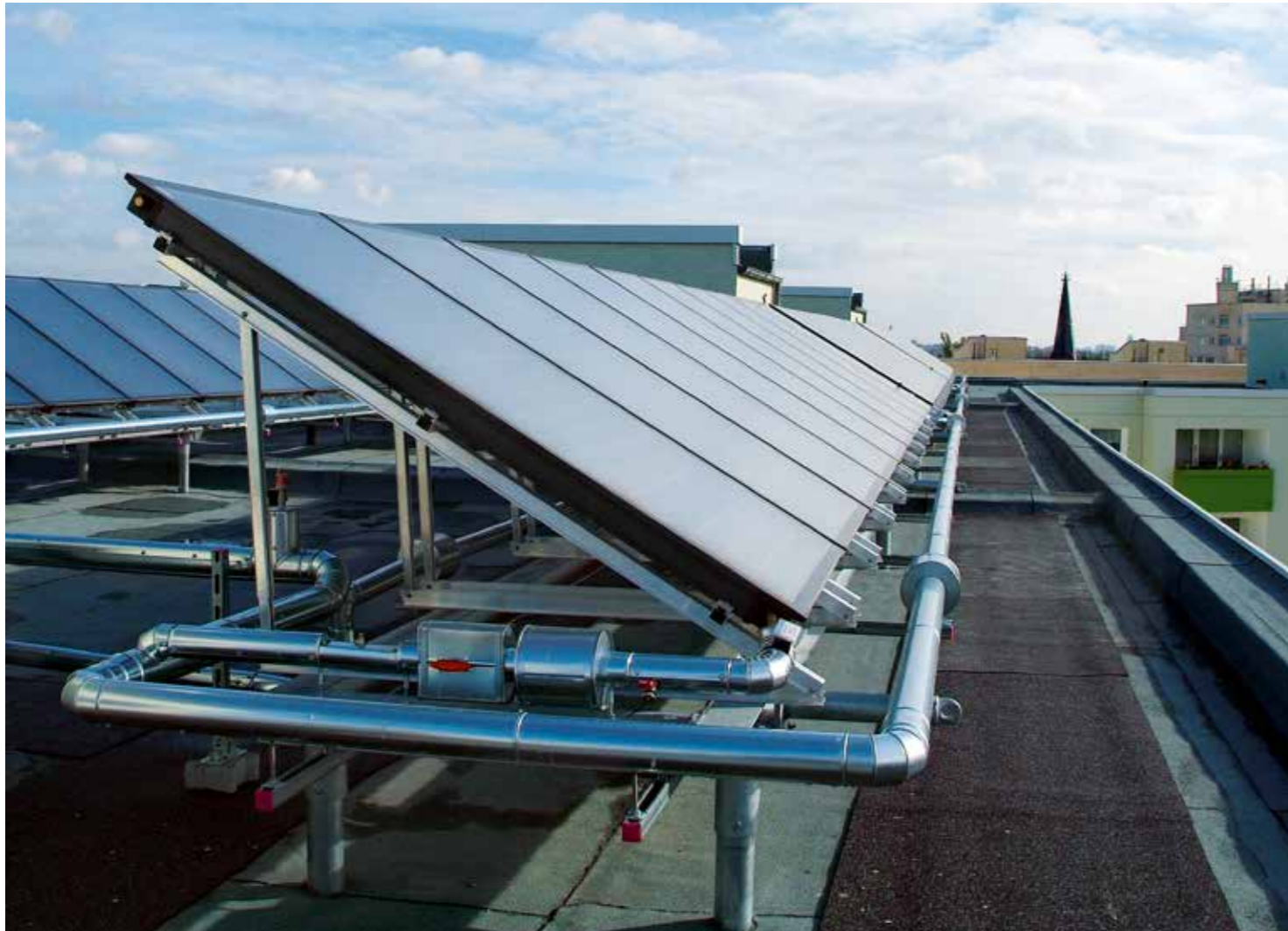
Abb. 1: Aufgeständerte Solarkollektoren auf einem Hochhaus in Berlin
