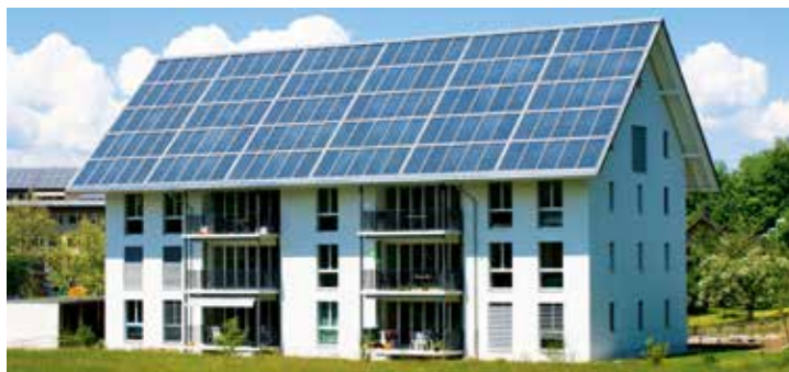
Abb. 14: 100 Prozent Solarwärme im Mehrfamilienhaus
